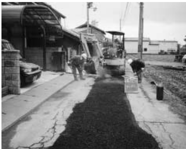
▲豊田地区污水管渠築造工事(下水道工事)の様子
