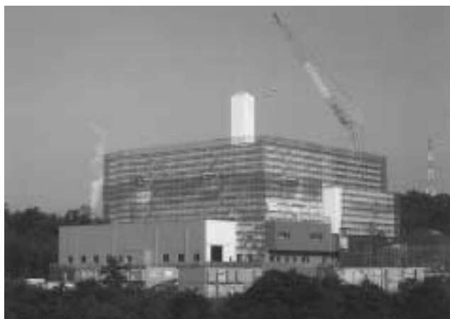
▲建設中の「中部清掃組合日野清掃センター」 平成19年4月に本格稼働します
