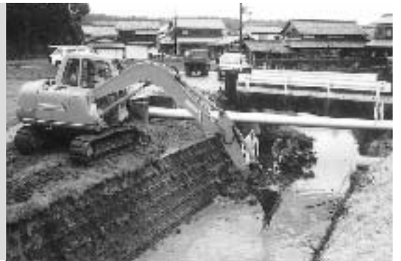
▶重機やスコップで川底に溜まった泥を取り除いています
