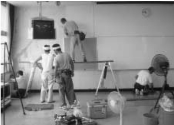
▲建築組合の皆さんにより、手際よく壁紙が張り替えられました
