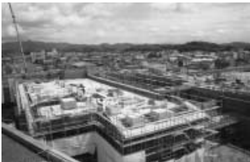
▲ 8月21日の中学校工事の様子
