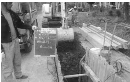
▲公共下水道工事
