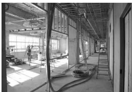
▲2階グラウンド側の教室
