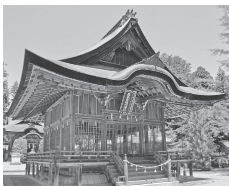
▲享和3年竣工の馬見岡綿向神社拝殿
