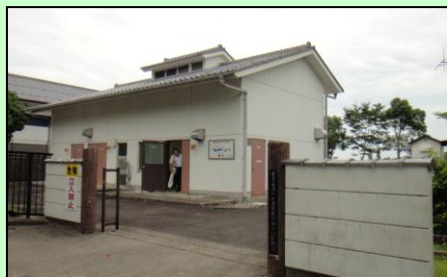
砂川処理施設の建屋
