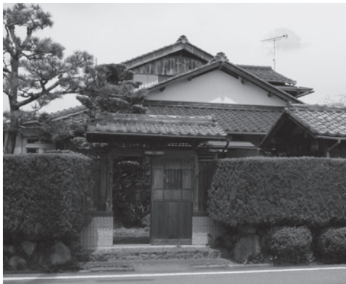
東側から見た岡家住宅主屋・門の外観
