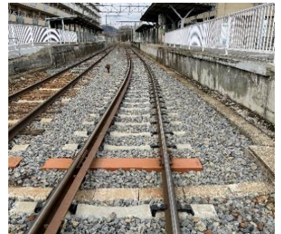
▲コンクリート枕木へ更新(彦根口構内)
