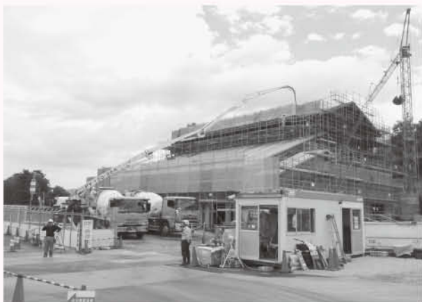
工事中の布引斎苑(八日市布引ライフ組合)
