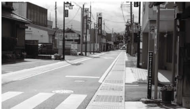
整備された町道側溝 (大窪地先)
