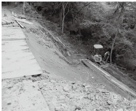
土砂災害復旧工事現場の様子
