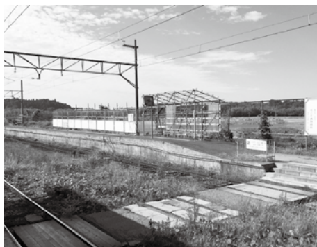
改修中の上りホーム上屋（日野駅）
