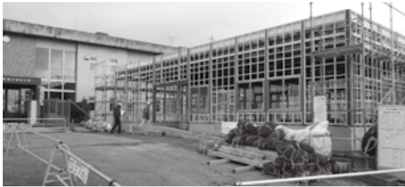
工事中の「ぼけっと」(奥が日野町勤労福祉会館)
