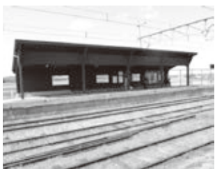
完成した上りホームの上屋
