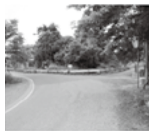
第1工区と第2工区の分岐、賀川神社前。現道は大きく左折し常永橋へ進む。
