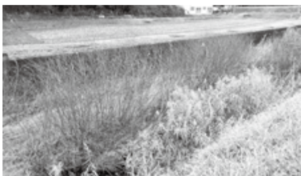
雑木が繁茂している一級河川
