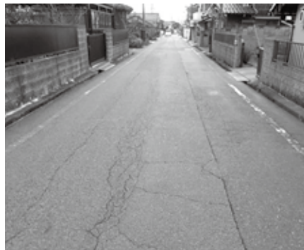
上野田地先の道路際の雨水排水路
