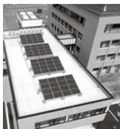
防災センター太陽光パネル
