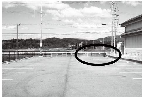
西大路公民館駐車場に確保された連絡所予定地（マルで囲った部分）
