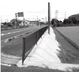
▲役場前 県道508号線路肩法面
