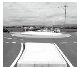
▲内池地先のロータリーと分離帯
