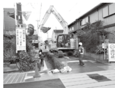
雨水排水渠整備工事が行われている岡本町
