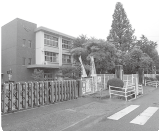
歩道新設予定のある必佐小学校前道路
