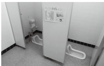
日野小学校体育館女子トイレの和式トイレ
