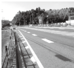
道路拡幅4車線化を求める国道307号
