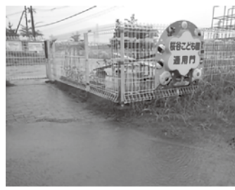
通用門付近の雨水による浸水箇所
