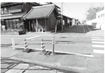
破損したガードレールは取外されている
