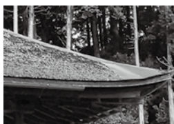
正明寺本堂の檜皮葺大屋根が美しい
