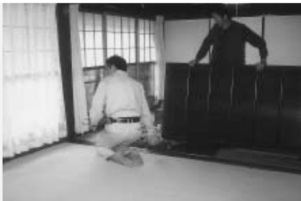
▶建具の建て付け修繕作業の様子
