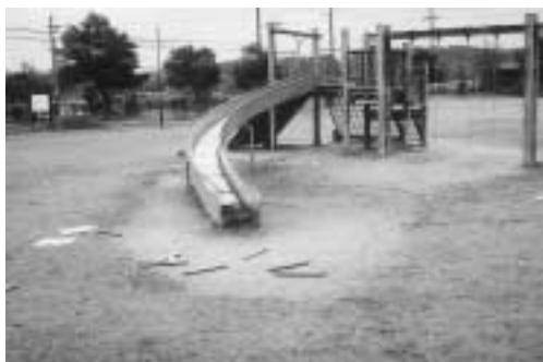
▲ローラーが取り外された滑り台
