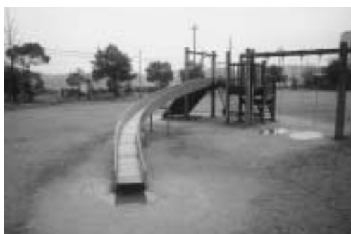
▲修理された滑り台
