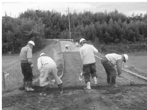
▲コンクリート舗装工事の様子
