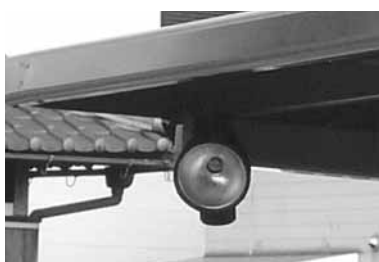
▲早速中学校に設置させていただきました
