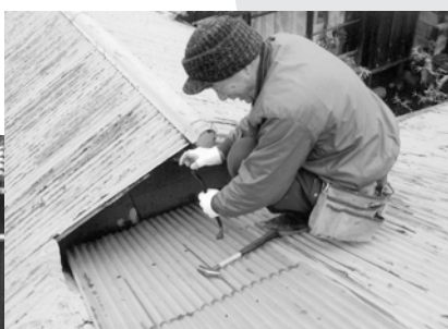
▲屋根に登っての修理
