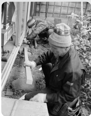
▲腰板補修作業
