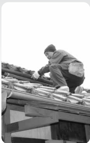
▲屋根瓦・とい補修作業
