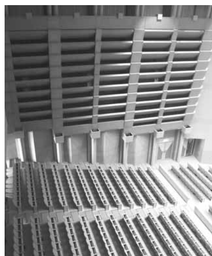
▲大ホールにある「残響可変装置」。開閉することで、音の響きを調整
