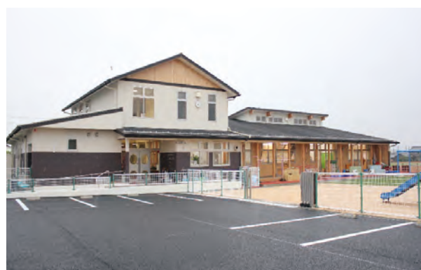
町産材等を活用した園舎改築(こばと園)
