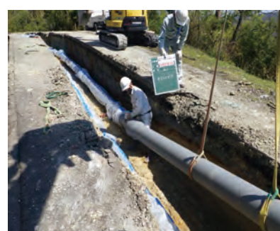
基幹配水管設置工事の様子
