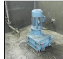
ODばっ気攪拌装置 (エアレータ)
