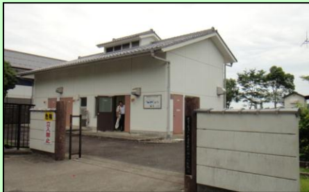
砂川処理施設の建屋
