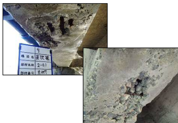
旧橋主桁でのうき（左）と剥離・鉄筋露出（右、判定Ⅱ～Ⅰ）【 0033_長沢橋 】
