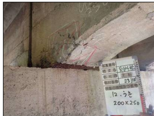
主桁端部の変形・欠損（左）と、主桁端部下面のうき（右、判定Ⅱ）【 0012_別所橋 】
