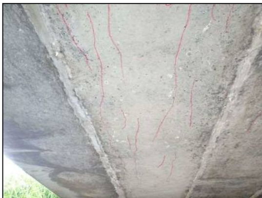
主桁下面の軸方向ひびわれ【 0017_松尾橋 】
