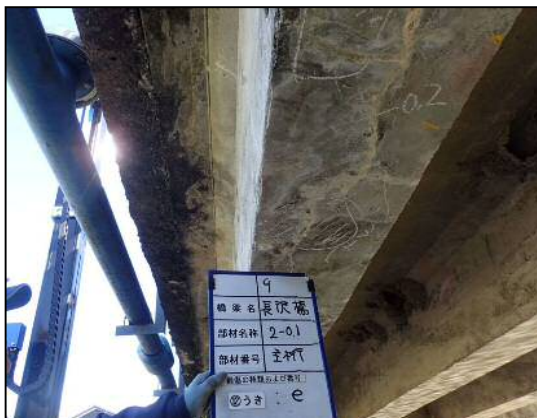
旧橋主桁でのうき（左）と剥離・鉄筋露出（右、判定Ⅱ～Ⅰ）【 0033_長沢橋 】
