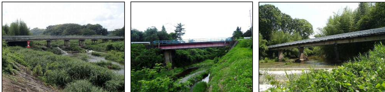
図 2-7 日野町の高齢化橋梁（橋長 15m 以上）
