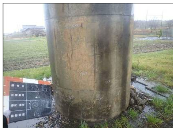
橋脚梁部（左）及び橋脚柱部（右）の亀甲状ひびわれ【 0044_広域跨線橋（石原橋）】
