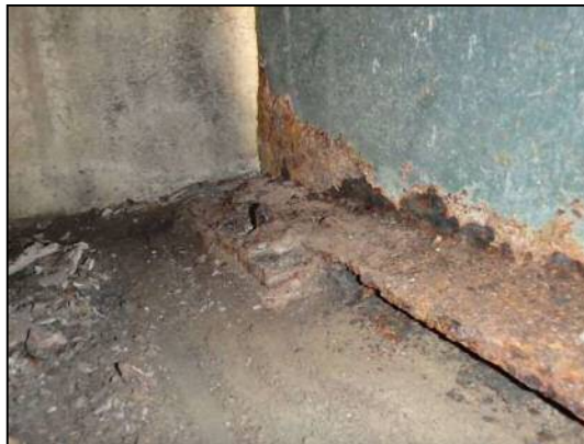
桁端部鋼材の腐食【 0022_西川原橋 】
