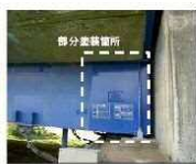
<部分塗装による補修>
