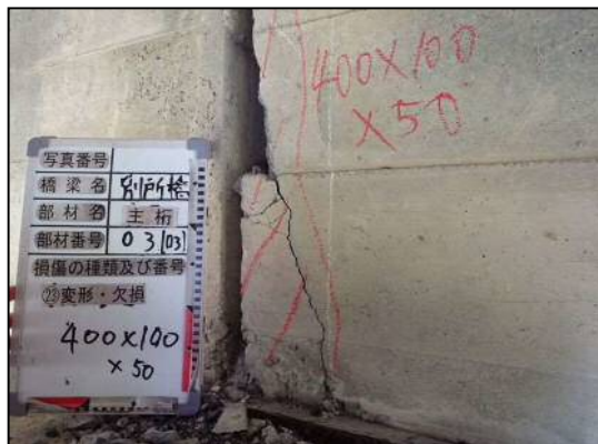
主桁端部の変形・欠損（左）と、主桁端部下面のうき（右、判定Ⅱ）【 0012_別所橋 】
