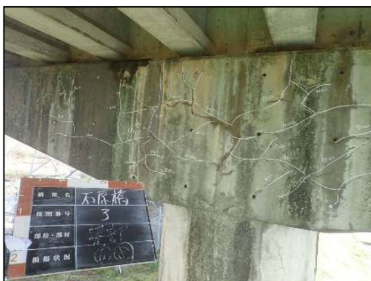
橋脚梁部（左）及び橋脚柱部（右）の亀甲状ひびわれ【 0044_広域跨線橋（石原橋）】
