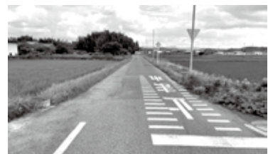
町道小御門線歩道新設工事
