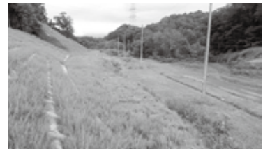
町道西大路鎌掛線道路改良工事
