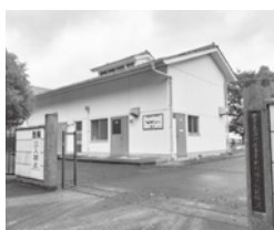
砂川処理施設の建屋
