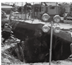
▲八潮市の道路陥没現場
