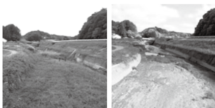
鎌掛 南砂川 浚渫前
