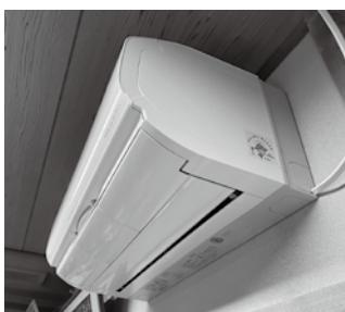
▲設置されたエアコン
