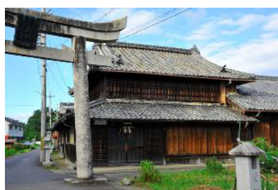
大字西大路集議所 （元西大路藩藩邸勘定部屋）
