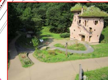
園路舗装 (土系硬化舗装)
