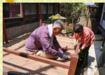
棧敷の床を組み立てる様子
