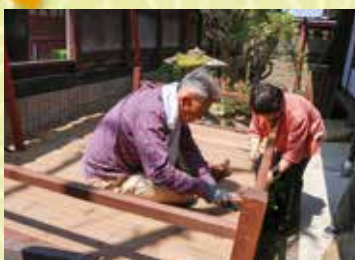
棧敷の床を組み立てる様子
